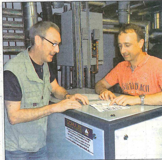
Moderne Blockheizkraftwerke decken jetzt zu großen Teilen den Energieverbrauch bei Emmaus in Niesky. Foto: Emmaus Niesky
